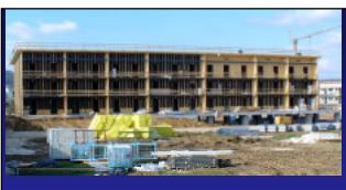
Uno degli edifici fase di costruzione: struttura portante in cross-lam (X-lam), le strisce nere sono pannelli isolanti a base di sughero.
